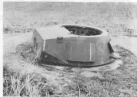
Tysk bunker med kampvognstårn i Frederikshavnsområdet.
