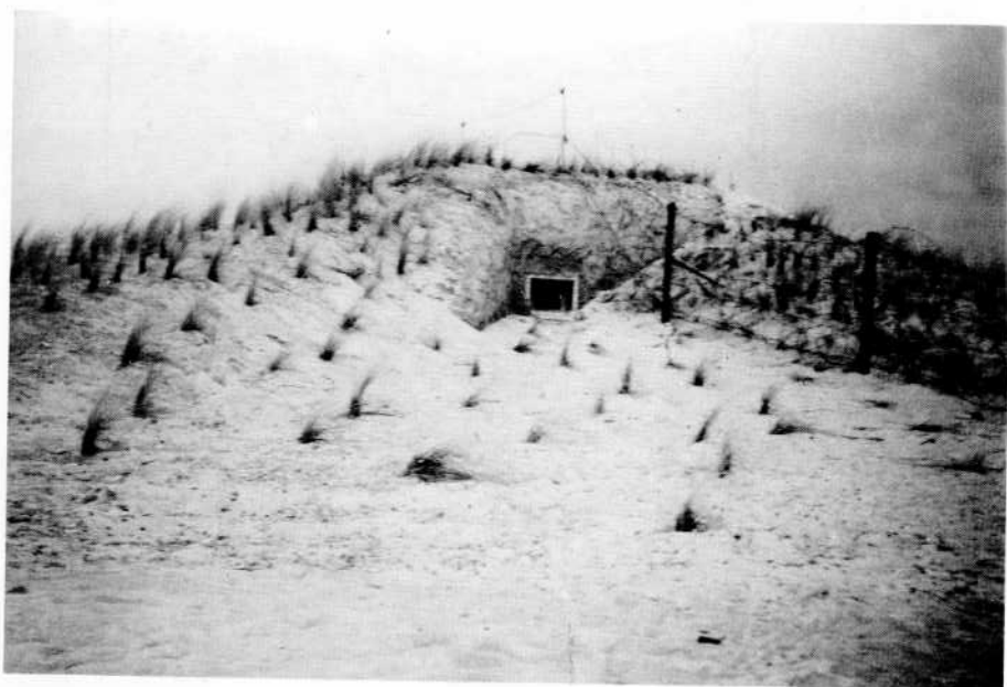
Überdeckter und getarnter F - Stand an der Küstenstrecke südlich von Nymindgab. Es ist hier zu sehen, wie ein Stacheldrahthindernis über die Decke des Standes, mit Hilfe von Runderisen geführt wird. (Foto: Ejnar Nielsen via John Hansen)
