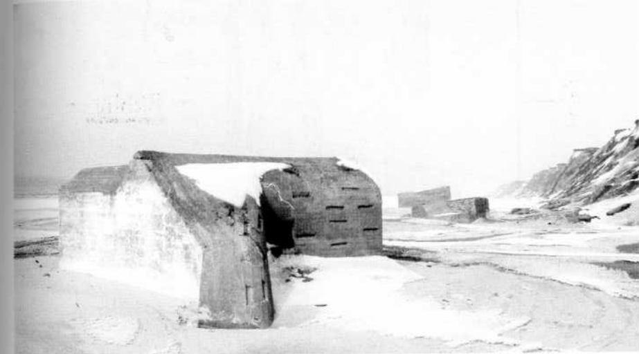
Flankierungsgruppe hart nördlich der Marineküstenbatterie Lökken Nord. Die Stände sind um 1980 auf den Strand abgerutscht. (Foto: Verfasser 1986)
