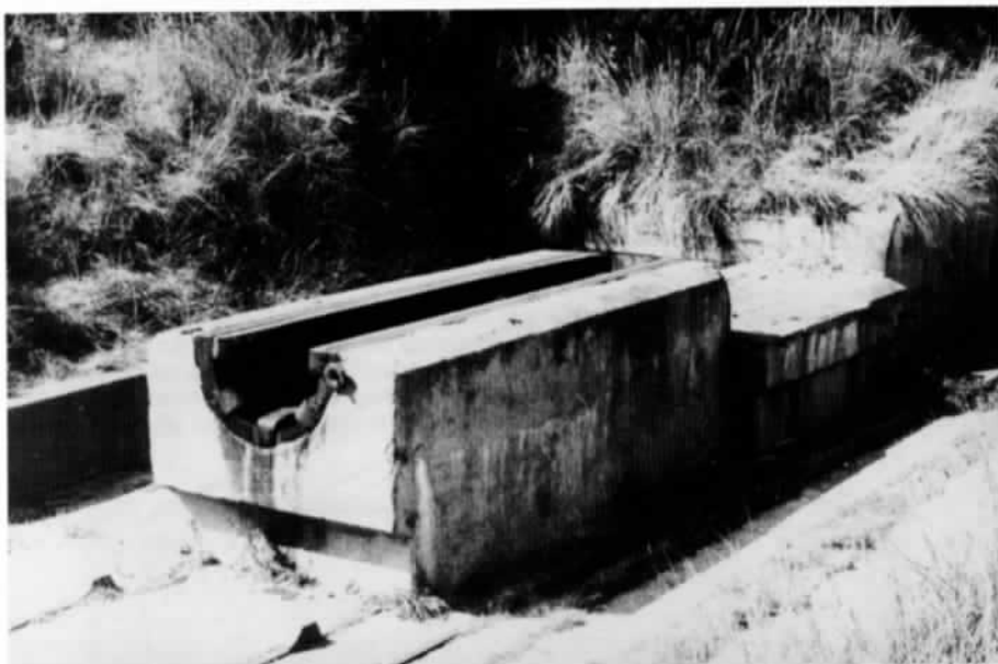
Aufnahme des Betonfundaments für das Ladeübungsgerät von Südosten her gesehen. (Peer Vesterager, etwa 1974)
