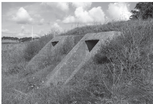
Den lille beskyttelsesbunker, som i dag er den mest synlige del af skinanlægget. (Museumscenter Hanstholm).
