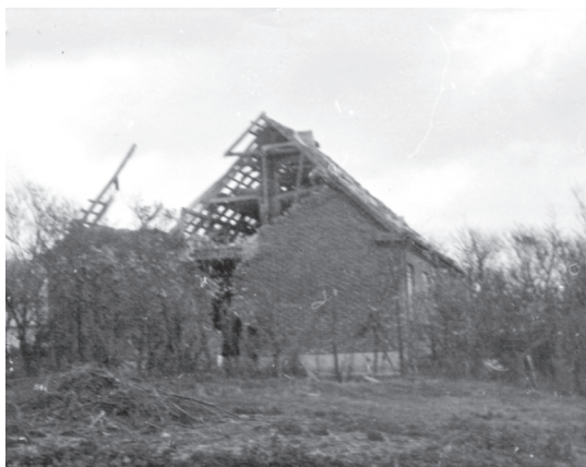
Den beskadigede vestgavl på »Vestergård« stuehus. (Foto: Johannes Thomsen via Ib Nielsen)
