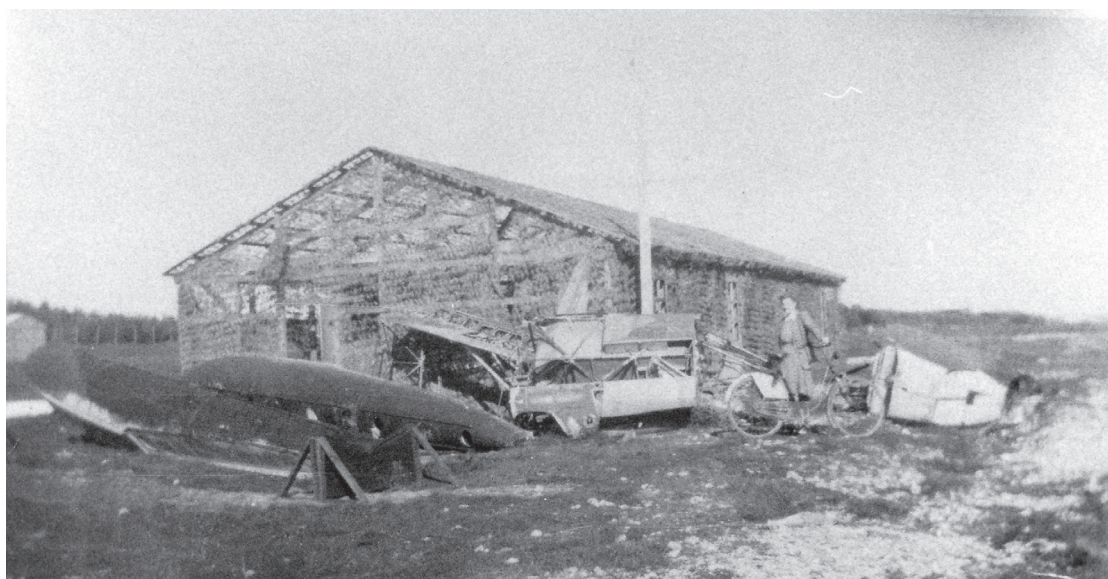
Fårtoft, 1945. Skinbygning, som må være opført efter juli 1942. Foran bygning ligger forskellige flydele, bl.a. pontoner. Bygningen til venstre i billedet er rimeligvis »radiostationen«. (Lokalhistorisk Arkiv for Thisted Kommune).
